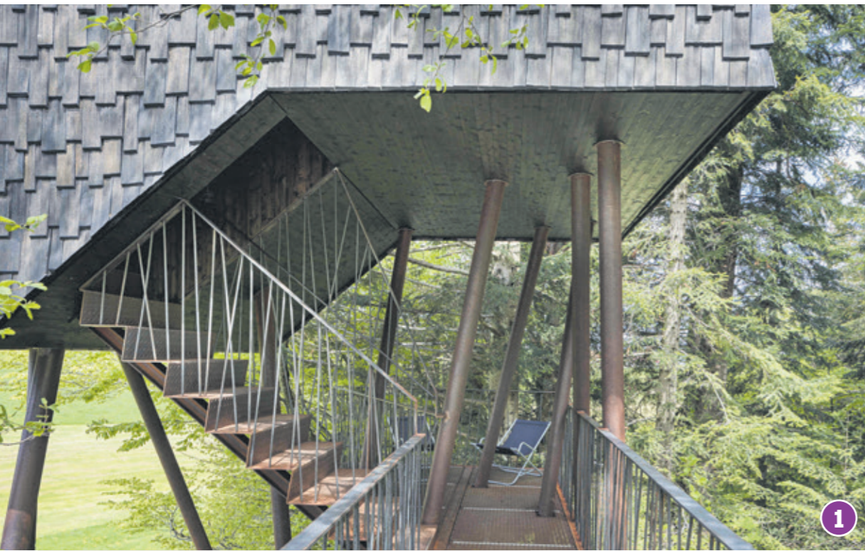
1 Dreizehn schräg gestellte Cortenstahlstützen tragen das Baumhaus, zwischen ihnen führt eine Treppe nach oben in die Garderobe.
