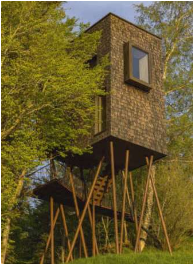
Einem Wipfelpfad gleich, führt die Zugangstreppe mit Rampen durch den Stützenwald, der den Wohnkubus zum Baumhaus macht
