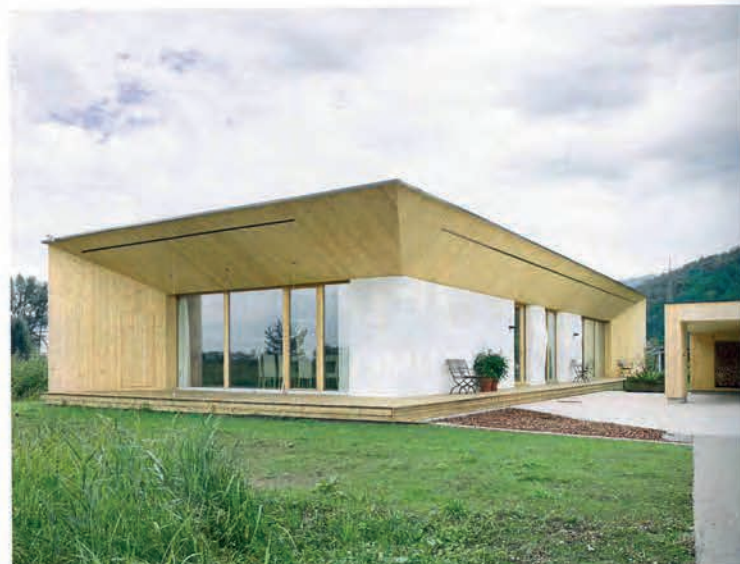
In den 120 Zentimeter tiefen Fensterlaibungen entstehen attraktive Aufenthaltsbereiche mit Blick in die Natur. • The 120-centimeter deep window reveals provide attractive sitting areas with a view into nature.
