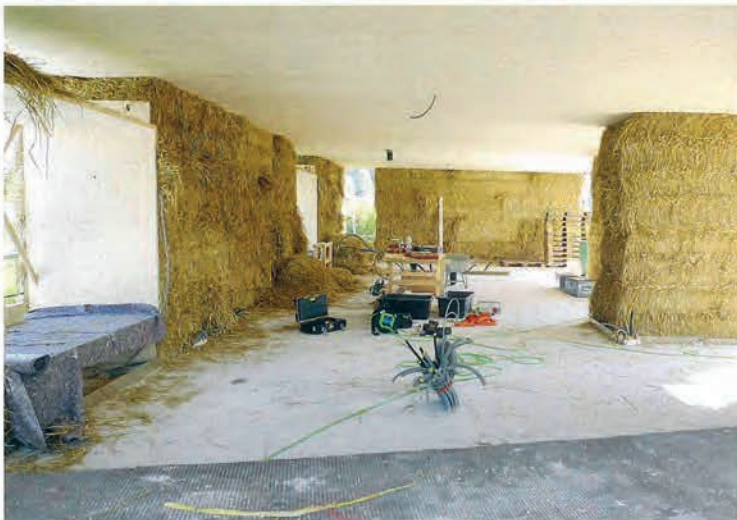
Die aufeinandergestapelten Strohballe tragen ... • The stacked up bales of straw ...
