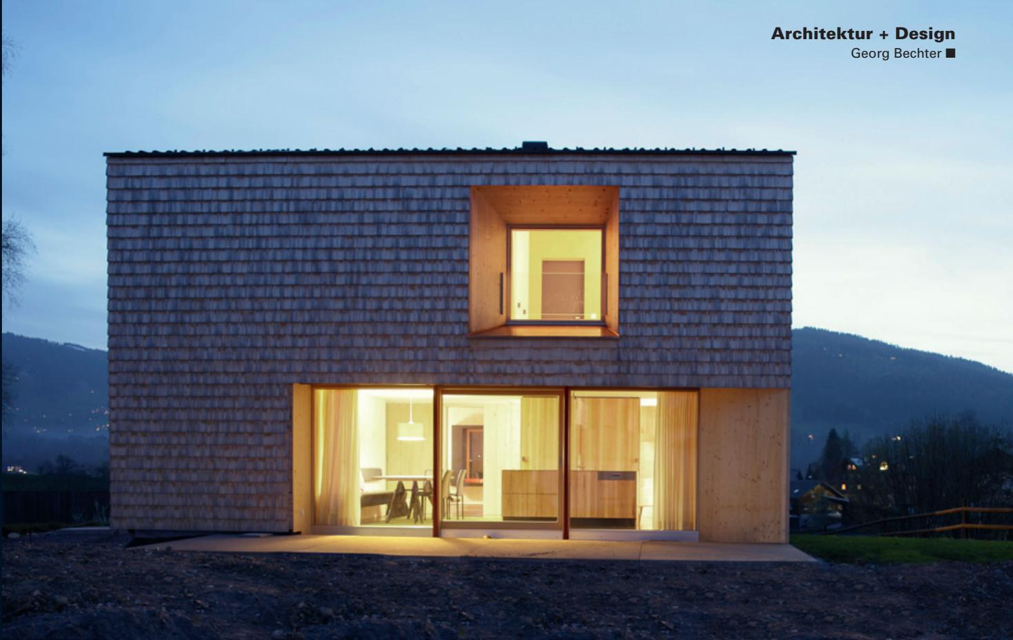
Als Isolierung der verschindelten Gebäudehaut dienten 45 cm dicke Strohballen. Die neu eingeschnittenen Fenster zeigen sich konisch und erlauben einen hohen natürlichen Belichtungsgrad. Gebäudevor- und -rücksprünge wurden begradigt und auskragende Dachränder gekappt. Moduliert durch die Summe dieser Eingriffe entstand ein moderner, plastischer Baukörper mit skulpturalen Charakter, der sowohl in der Formensprache als auch in
