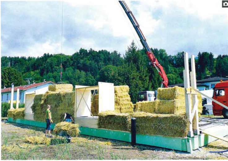
Die aufeinandergestapelten Strohballen tragen ... • The stacked up bales of straw ...
