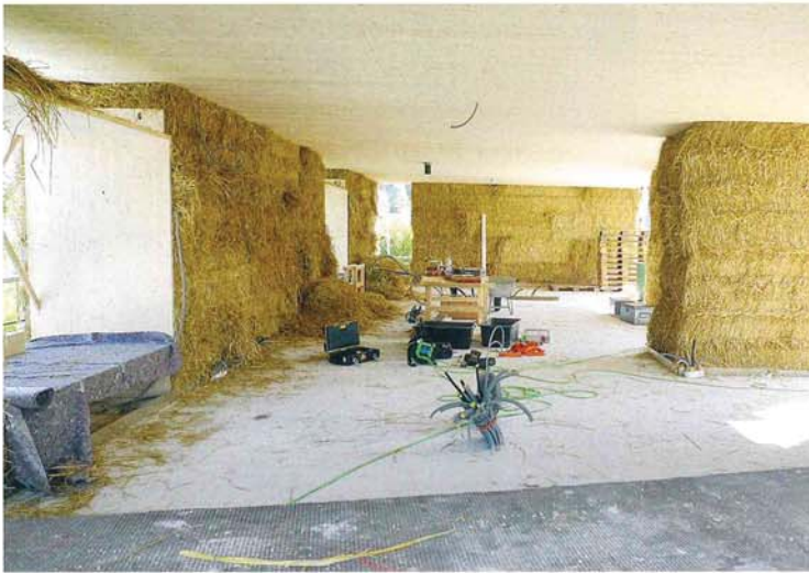
Die aufeinandergestapelten Strohballen tragen ... • The stacked up bales of straw ...
