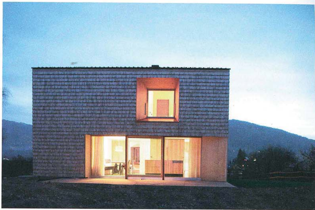
Nach dem Umbau schmückt ein Schindelkleid das Haus in Vorarlberg. | After conversion work, the Vorarlberg house is enhanced by a wood shingle skin.
